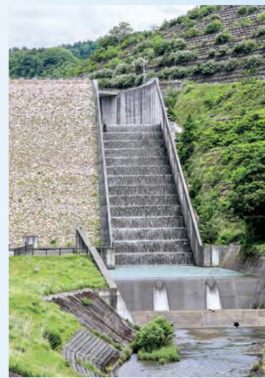
国内初の技術を採用した階段状の水路。1段は3m×8m。水の勢いを緩和できるため安全な放流が可能だ
